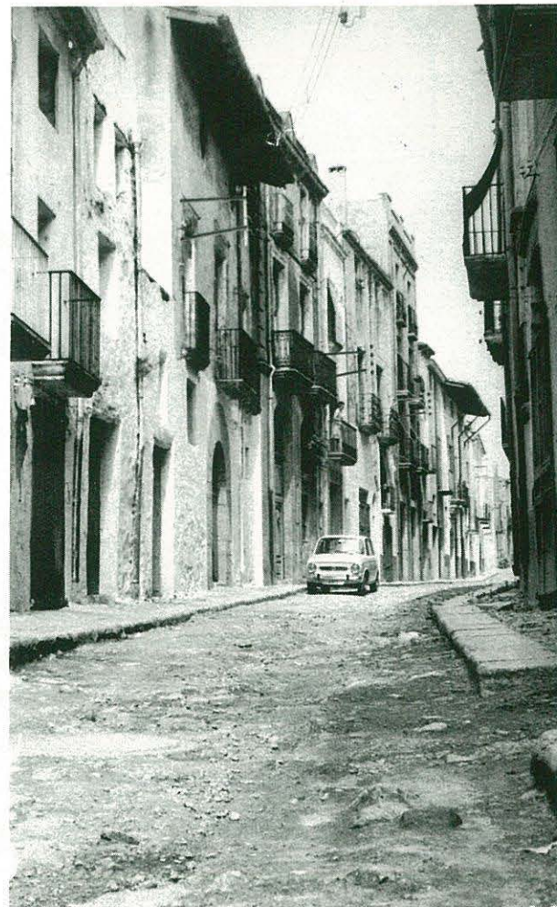
Estado actual de la calle Purísima
