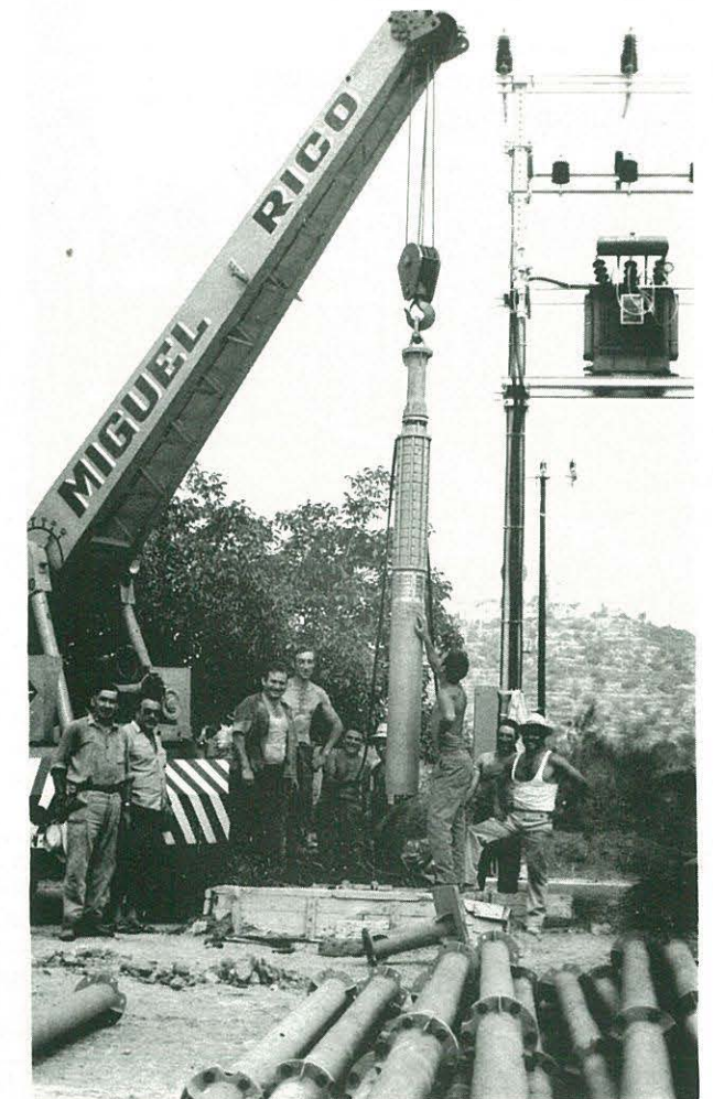
Colocación en el pozo, del grupo de bombeo
