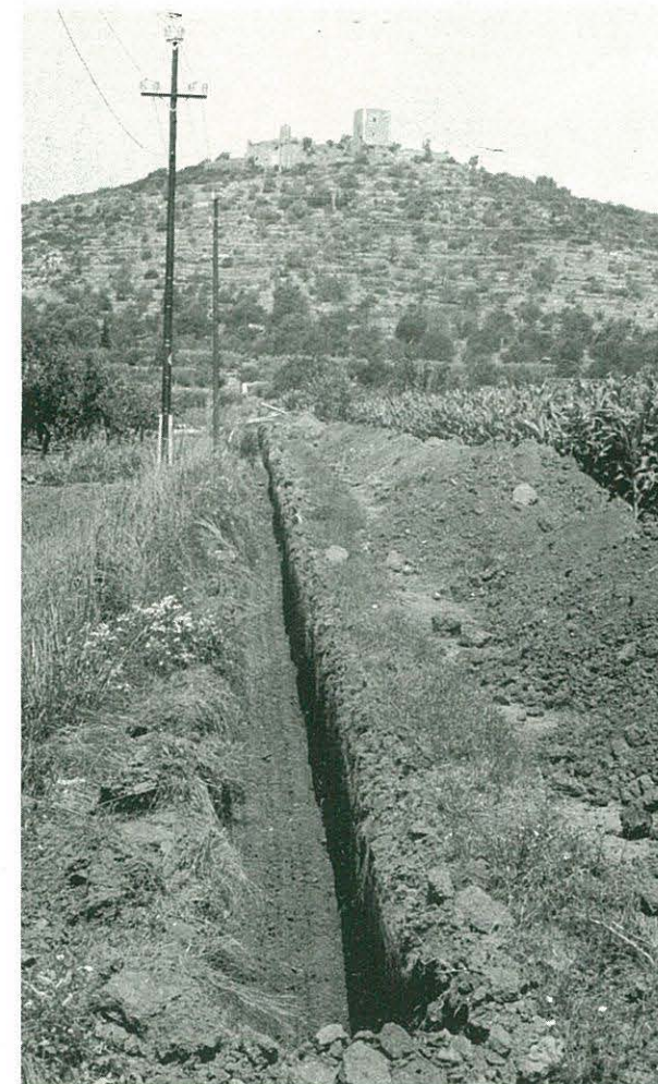
Zanja para enterrar la tubería de conducción
