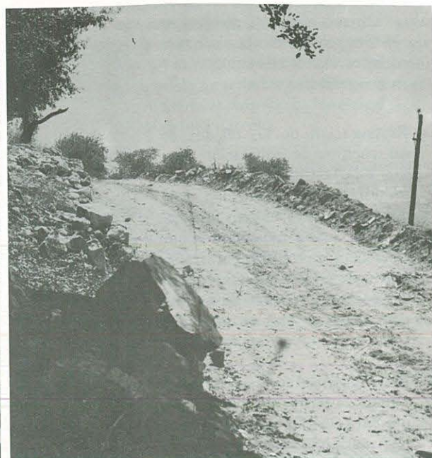
Construcción camino de acceso a zona obras
