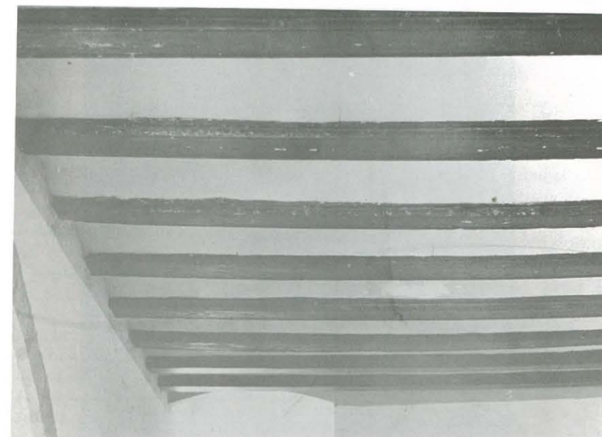
Forjado a demoler
