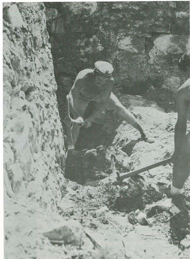
Catas en muro existente
