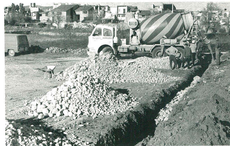
Vista general de los terrenos
