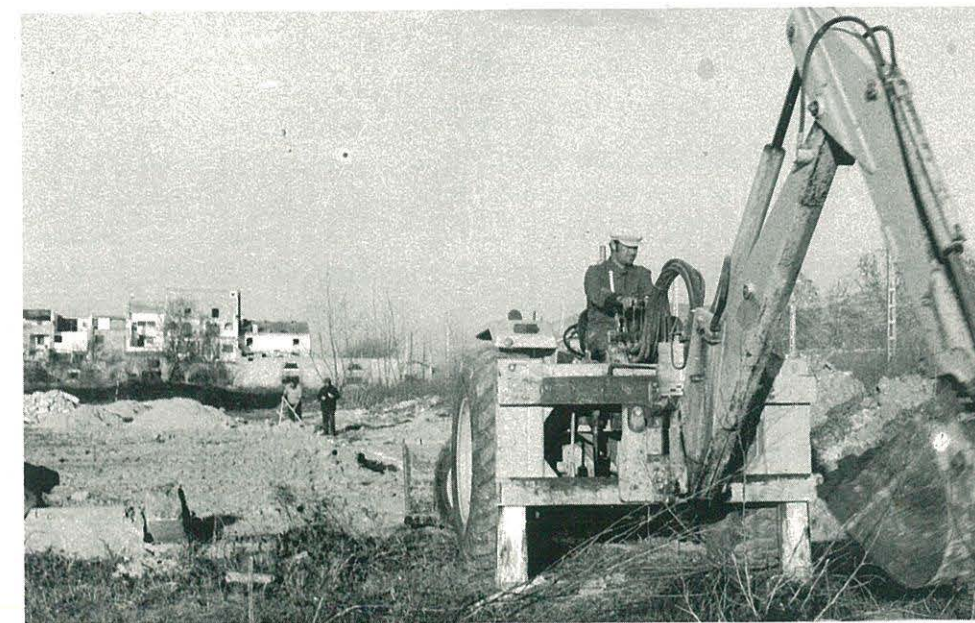
La máquina excavadora en plena actividad
