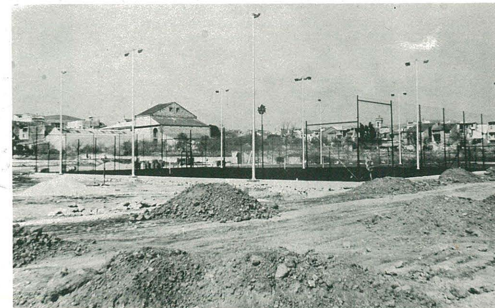
La foto nos muestra la cancha, con las farolas de iluminación colocadas.
