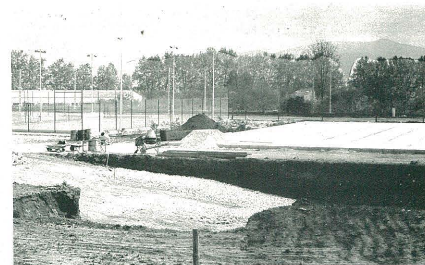
Pista polideportiva y vaso de la piscina
