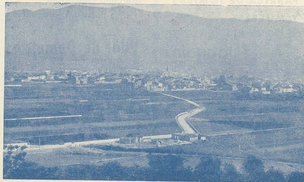
VISTA PANORÁMICA DE LA POBLACIÓN
