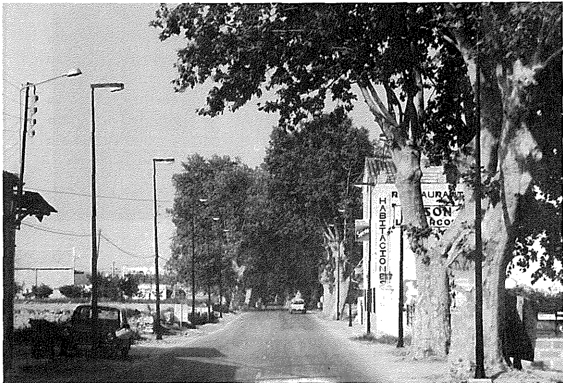
NOVA IL·LUMINACIÓ CARRER MAJOR I ACCESSOS A LA VILA
