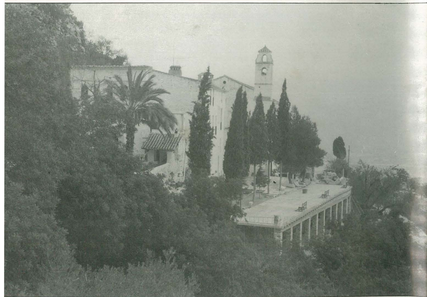
Altre aspecte de les obres a la plaça l'Ermita
