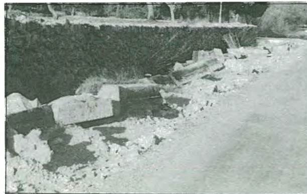
"Supresión bordillo carretera"
