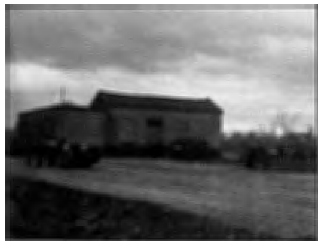
"Guarderías" (Ulldecona; Valentins; Castell) Obres restauració i conservació edificis
