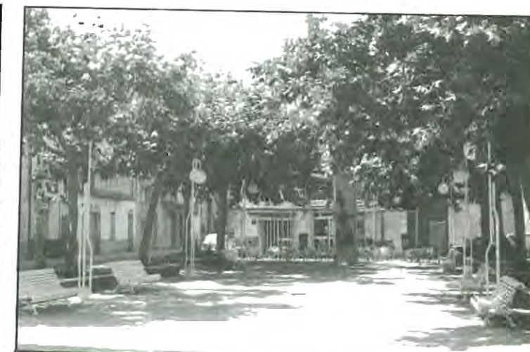
Obres a la Plaça Sales i Ferré
