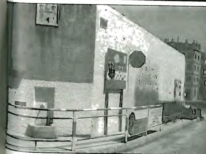
Reestructuració voreres C/. Mar - Major
