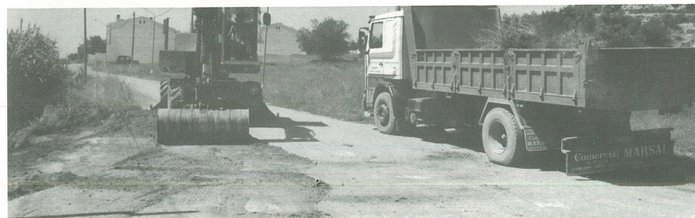
Iniciats els treballs d'arranjament de camins
