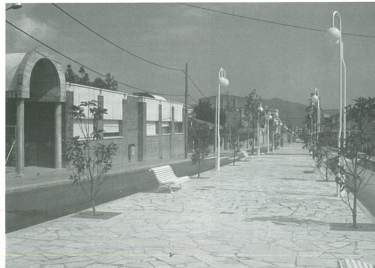
Acabades les obres de l'Avinguda Generalitat
