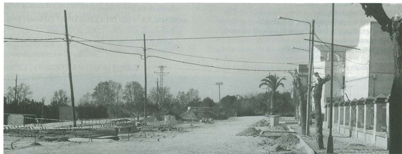
Obres Avgda. Escoles
