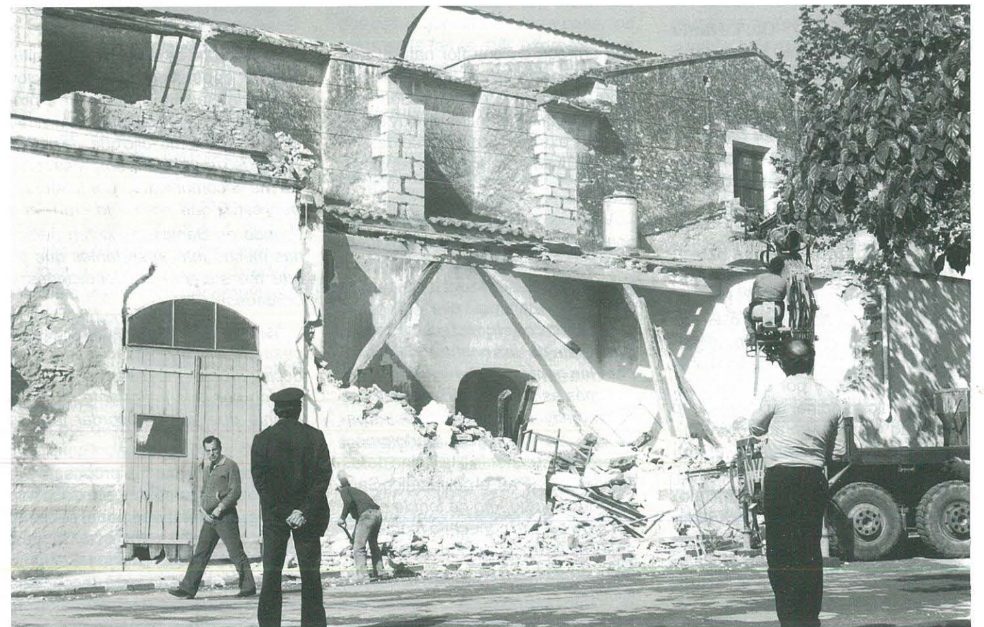
Inici d'Obres de la Casa de Cultura. Demolició de peixateries i escorxadors. Foto: Arxiu
