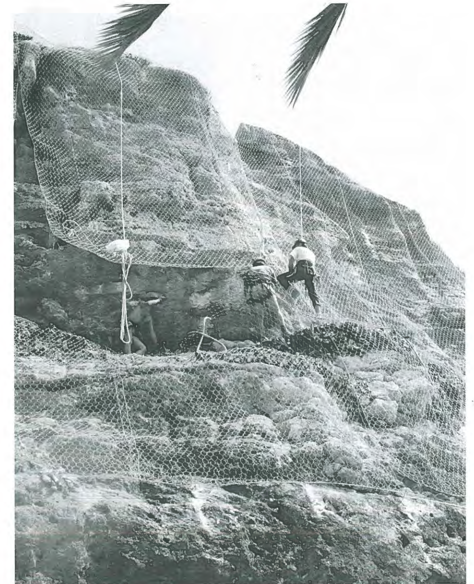
Aspectes de la col·locació de la xarxa de protecció a dalt del pati de l'Ermita
