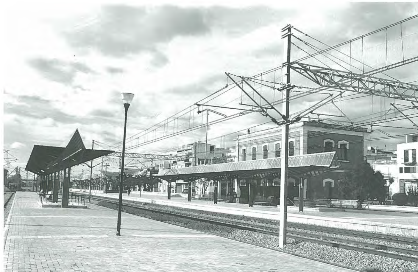
Aspecte actual de l'estació d'Uldecona
