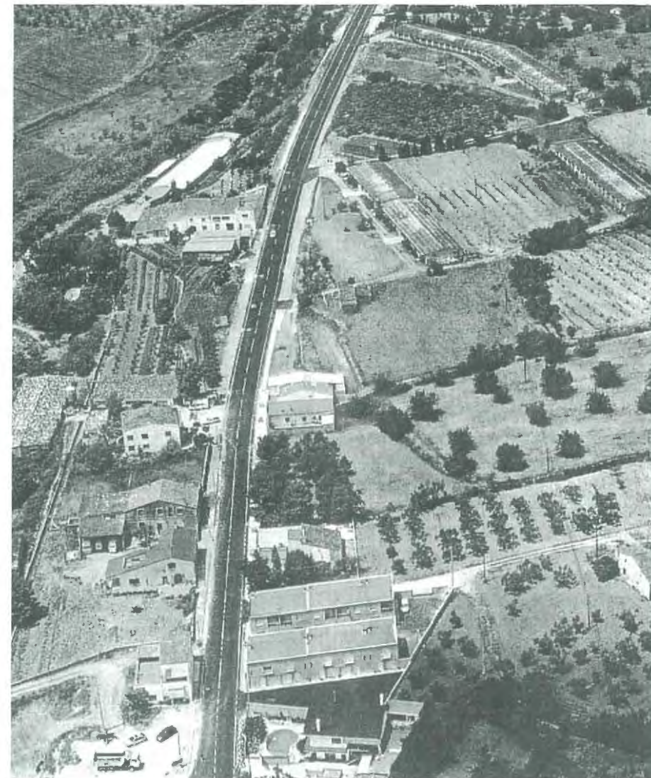
Vista aèria de la nova carretera acondicionada, del barri Castell a la Sénia
