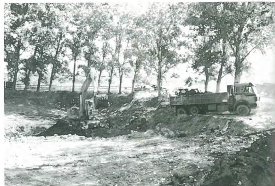
Treballs neteja. Bassa Ventalles
