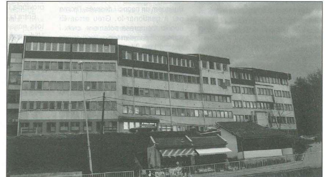
Rehabilitació Hospital General de Tesans
