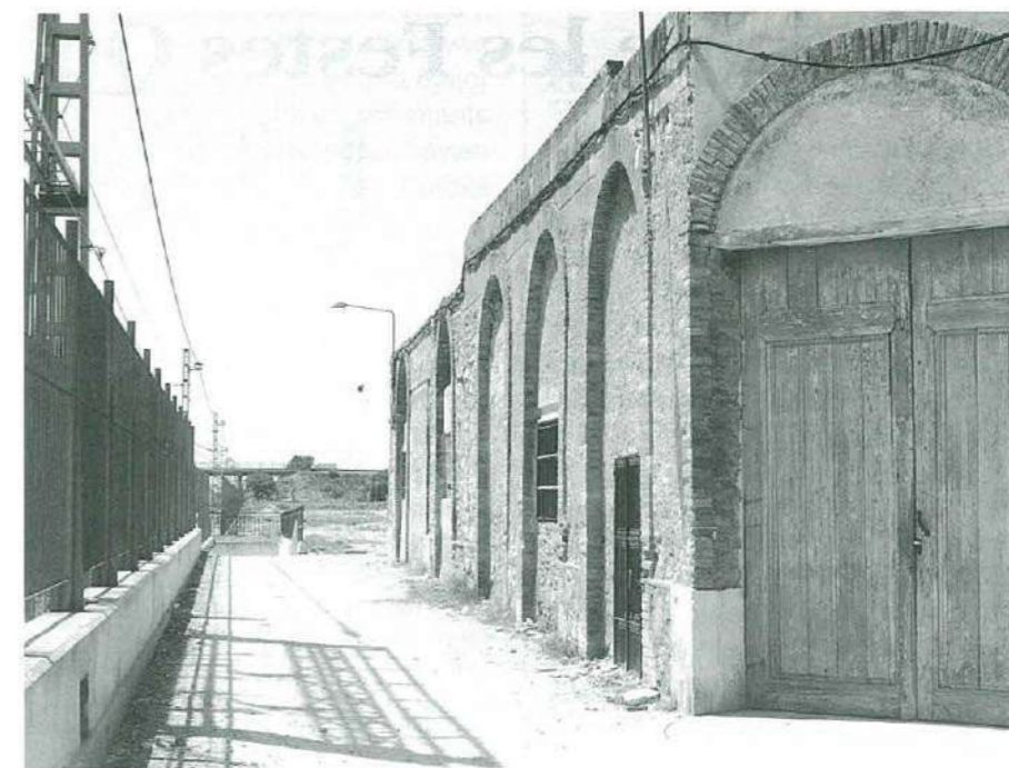
Ampliació Passeig Estació direcció Poliesportiu
