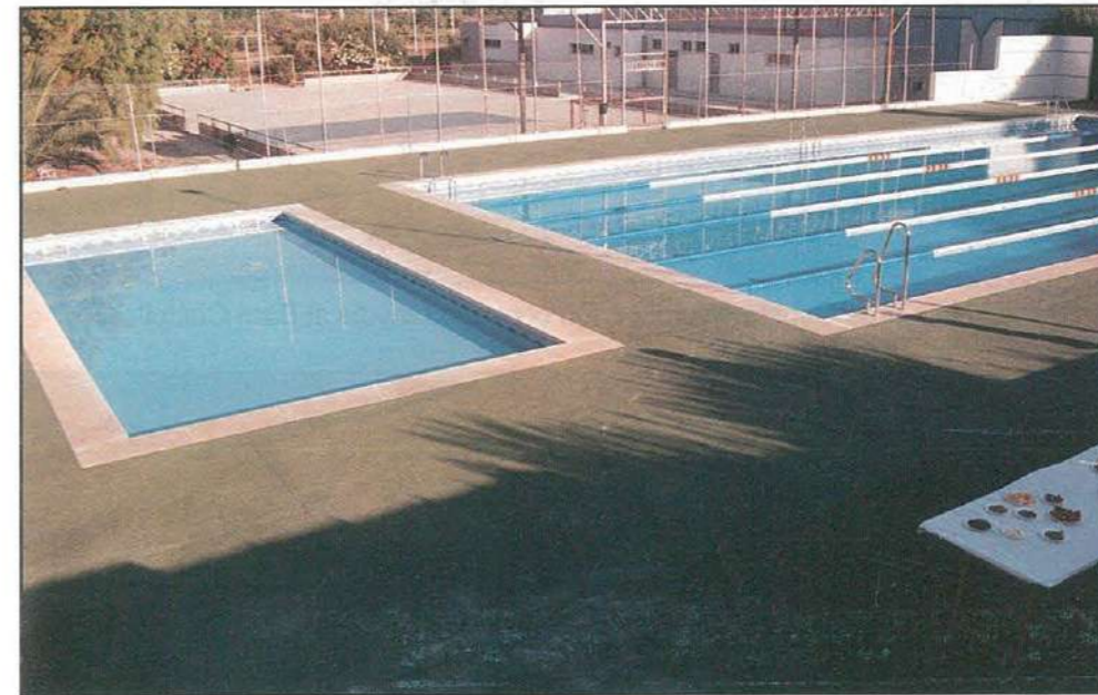
• Condicionament de les piscines municipals.
