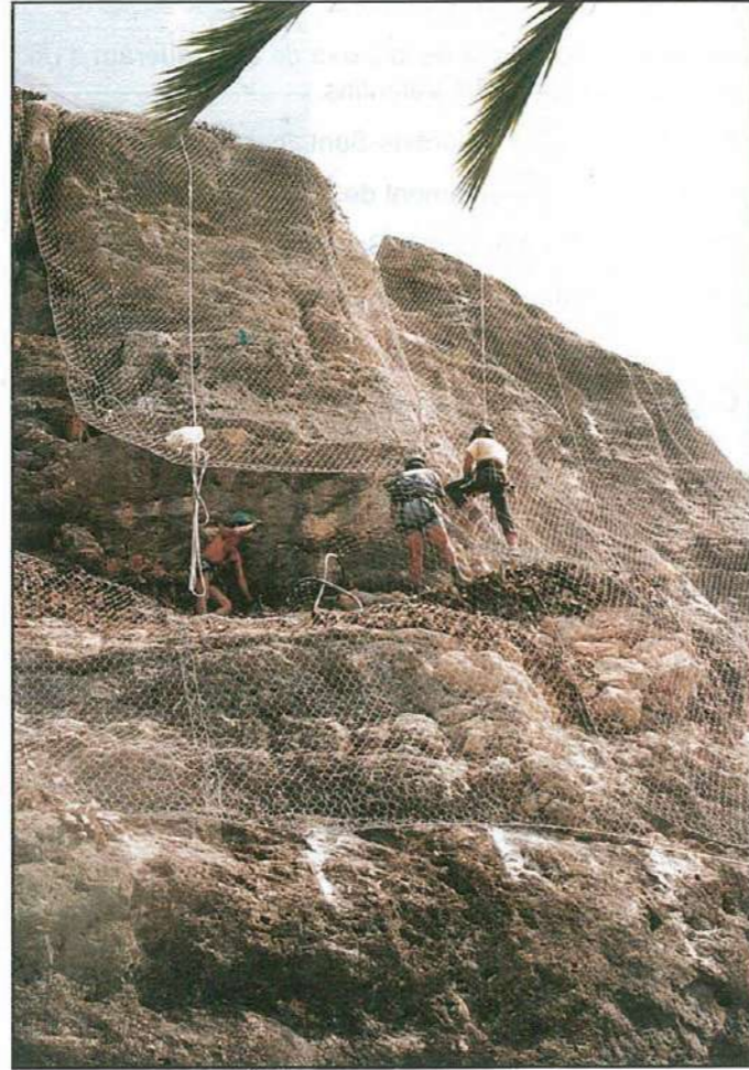
• Col.locació xarxa protecció pati de l'ermita.
