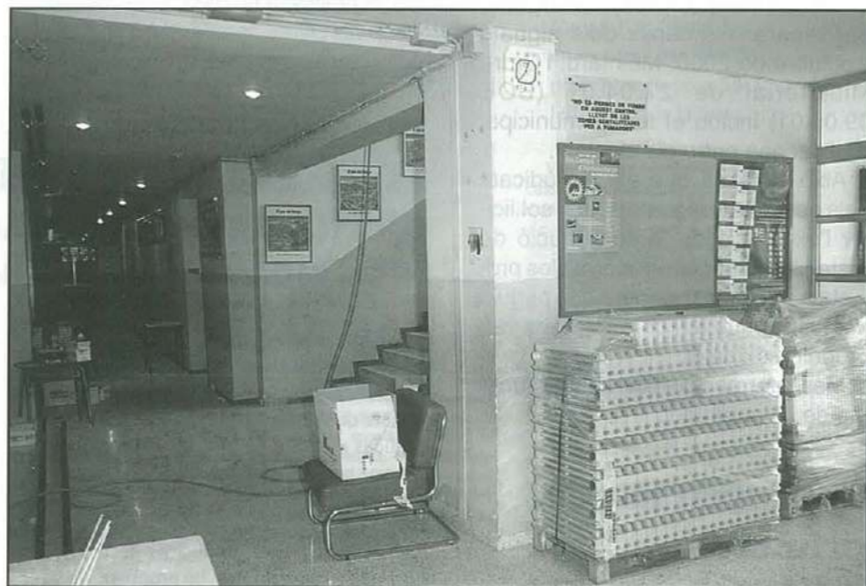
Col.locació calefacció menjador i edificis cicle mitjà del CEIP Ramón y Cajal
