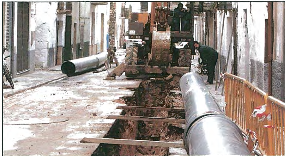
Aquesta fotografia correspon a les obres de construcció de la primera fase de la xarxa d'aigües pluvials
