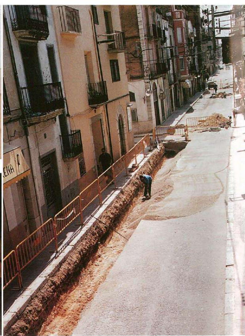
Segona fase del col.lector d'aigües pluvials
