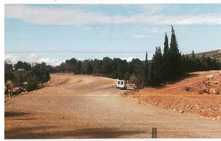
Obres carretera Ulldecona, Barri Castell
