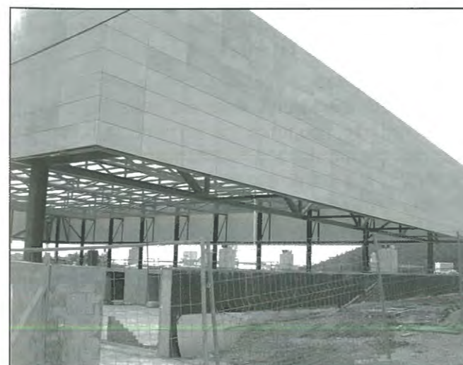
Construcció del nou pavelló poliesportiu, a l'avinguda Terrers
