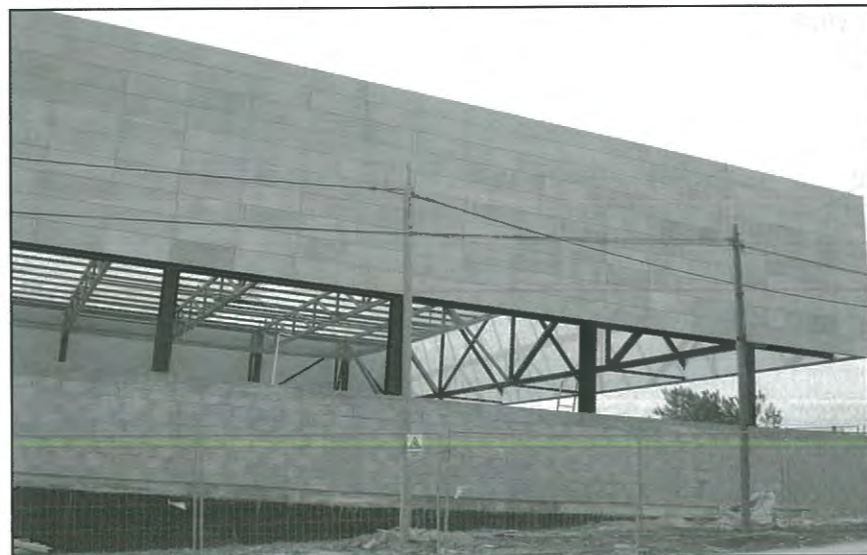
Construcció del nou pavelló poliesportiu, a l'avinguda Terrers
