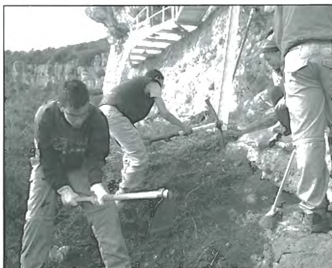
Alumnes de l'Escola Taller durant els treballs d'excavació
