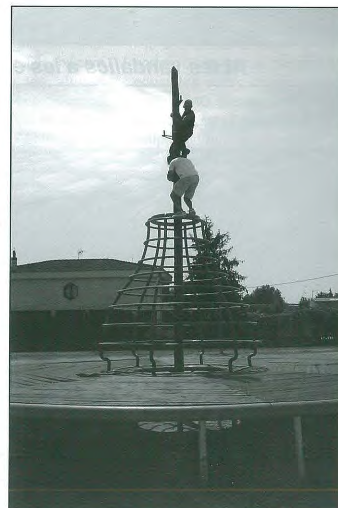
Preparació i instal·lació de la nova Plaça de Bous de les Festes Majors 2010.
